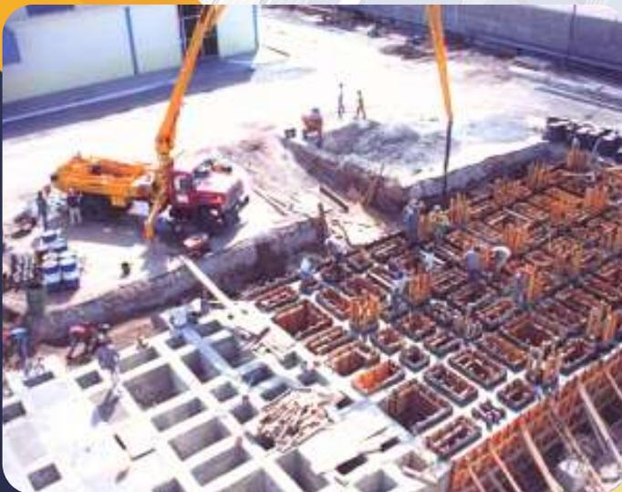
Construcción de cimentación y estructura para tanques universales
